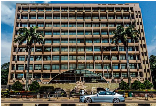
Fig. 11 Ahmed Talib House (Ten storey)
